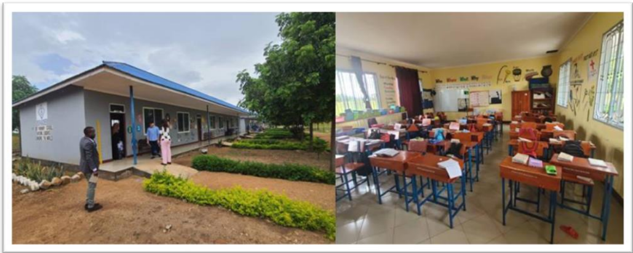
Pichani ni Baadhi ya Majengo ya Shule ya Msingi Inayomilikiwa na Shirika la SHADE Mkoani Shinyanga.
