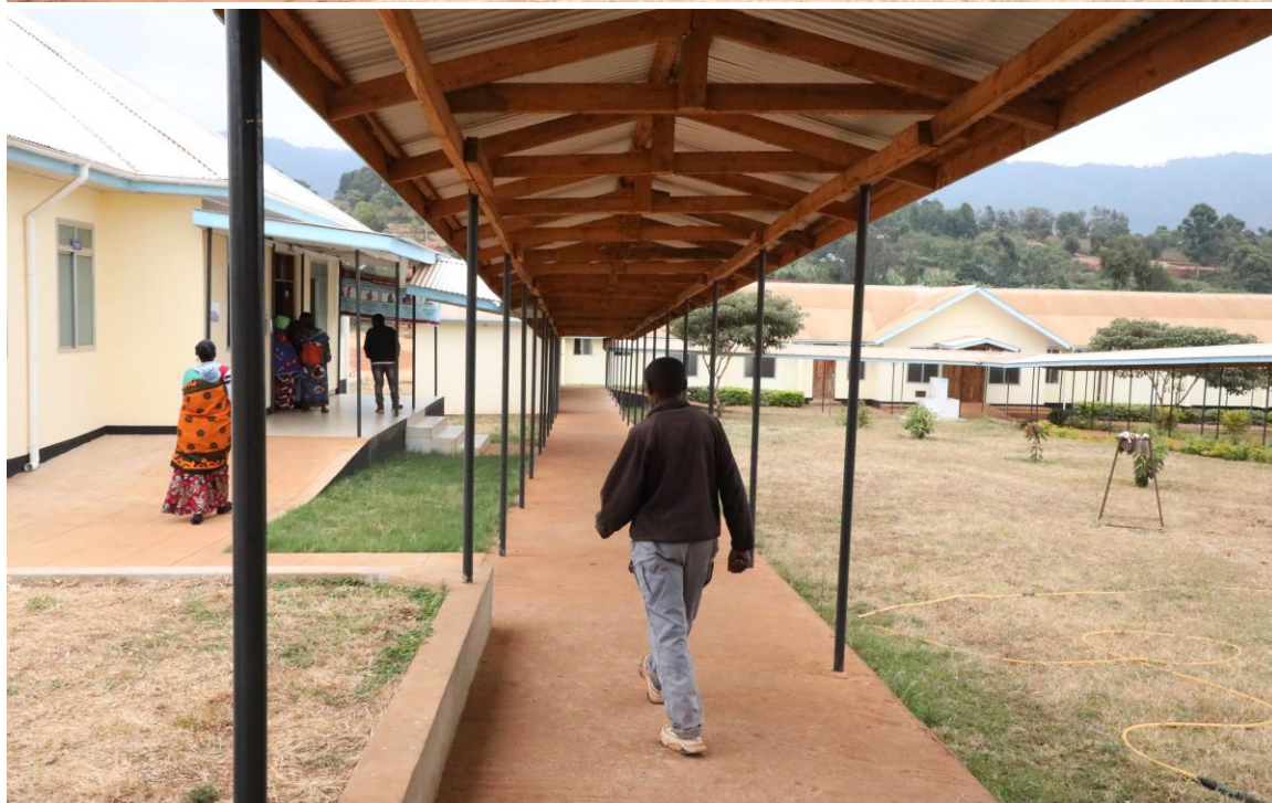
Pichani ni majengo ya Kituo cha Afya cha Dareda Kati kilichopo katika Kata ya Dareda Kati Mkoani Manyara. Ujenzi wa Kituo hiki umefadhiliwa na Shirika la Karim Heart of Spirit Organization
